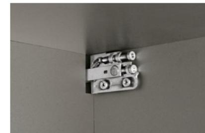
Der Hängeschrankbeschlag in Ganzmetallausführung hält starken Belastungen stand. Zur Ausrichtung ist er dreidimensional verstellbar.
